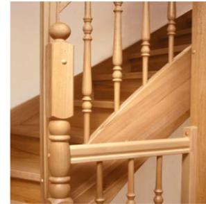
Gerade Holzwangentreppe, wandseitig eingestemmt, innen aufgesattelt in Buche bunt mit gedrechselten Pfosten und Stäben, mit Blockstufe und zurückversetztem Antrittspfosten.
