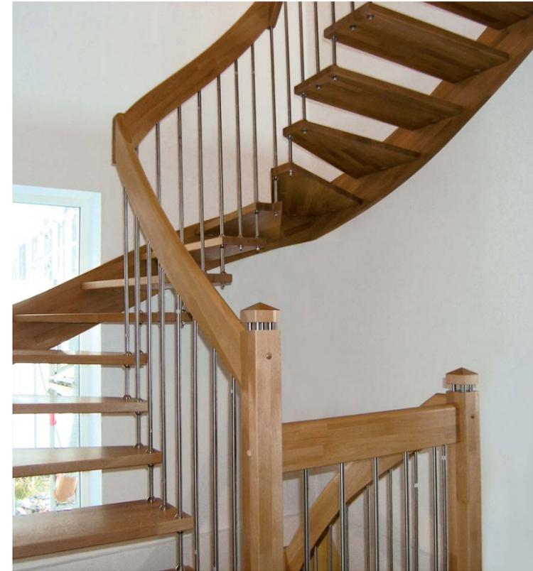
1/2 gewendelte Einwangentragbolzentreppe in Buche keilgezinkt hell mit Edelstahlstäben und einem Pfosten in Holz-Edelstahlkombination. Distanzhülsen hier in Edelstahl.
