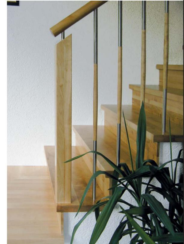
Birke Stufen mit Setzstufen, Edelstahl-Holz-Stäbe und einem runden Handlauf.
